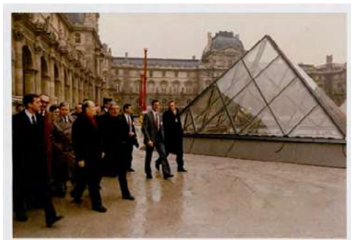
Reportage n°6328 : visite du chantier du Grand Louvre, 4 mars 1988. © Service photographique de la présidence de la République
