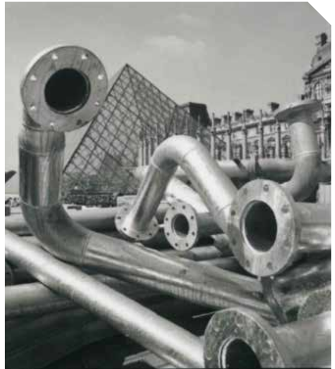
Construction de la pyramide du Louvre (1989). 20200206/7. © MIGT/OPPIC/Claude Bricage
