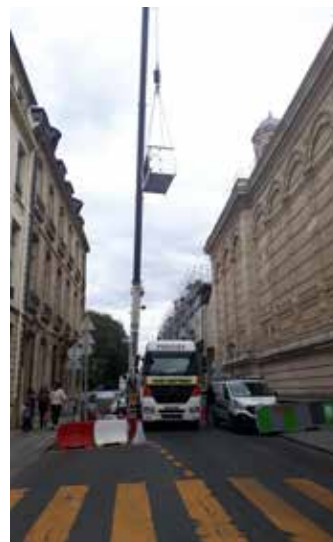
Travaux de couverture du Caran - arrivée des centrales de traitement d'air. © Arch. nat.
