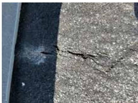
Fissuration de l'étanchéité
