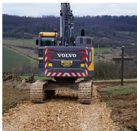
Une particularité importante concerne la partie boisée du chantier : en raison de la présence d'obus datant de la guerre, il est interdit de terrasser. Ainsi, les ouvriers ont opté pour une solution alternative en posant du géotextile suivi directement par la pose des cailloux.
