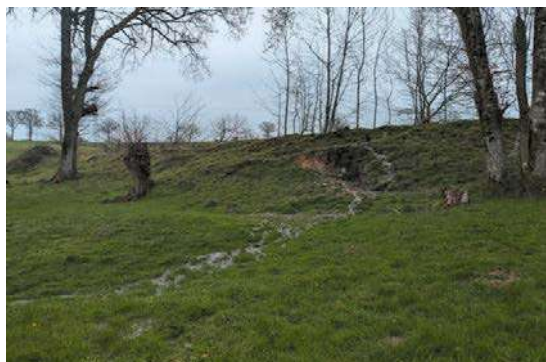
Chaussée déstructurée par les ragondins
