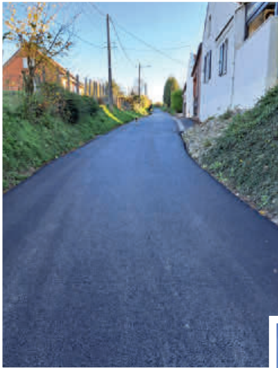
Travaux de voirie Rue Haute : Ducrocq TP Coût : 56 769 € Subvention FARDA : 15 000 €
