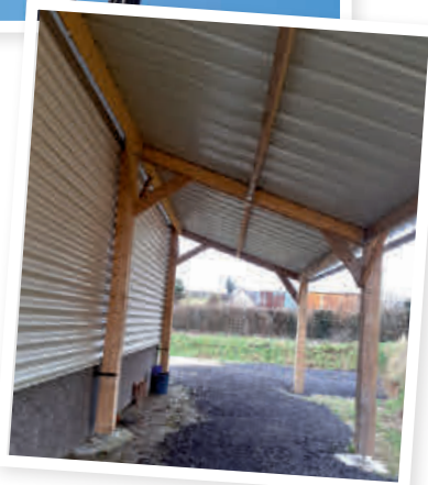
Carport : Personnel Communal Coût : 2 231 €
