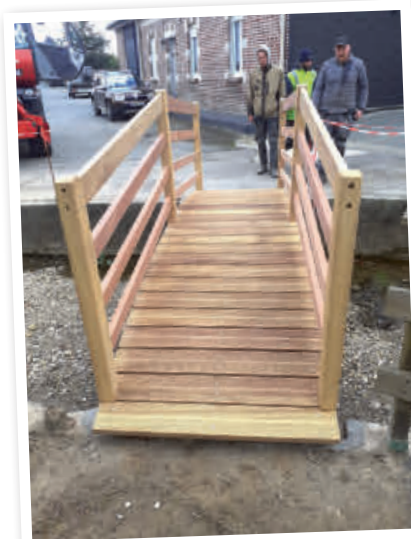
Passerelle rue du Moulin S. Ducrocq : 9 079 €
