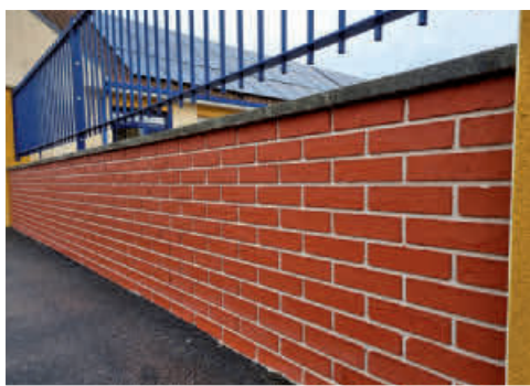
Muret Groupe Scolaire : GD Façades Coût : 4 643 €
