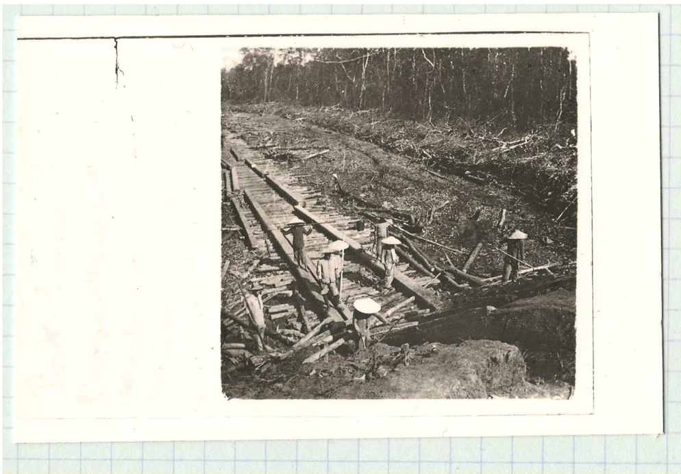
Port Inini, Construction de la voie Decauville, 1933, @photographie Famille Dupuy-Gatou
