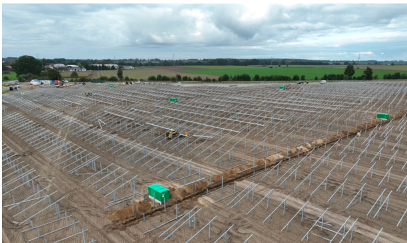
Installation en cours des panneaux solaires sur le site de Resko.
