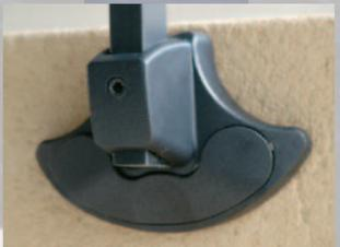
Finitions soignées pour ces rampes tout en rondeurs, élégantes et ergonomiques (embouts laqués placés à chaque coupe de profilé).
