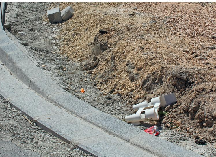
**INFOS** Le mortier joint doit être dosé à 200kg/m, ne jamais exéder 250 kg/m<sup>3</sup> avec un espace vide de 0,5 cm tous les 10 m
