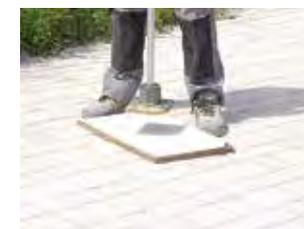
Compacter en utilisant une plaque protégée par un feutre
