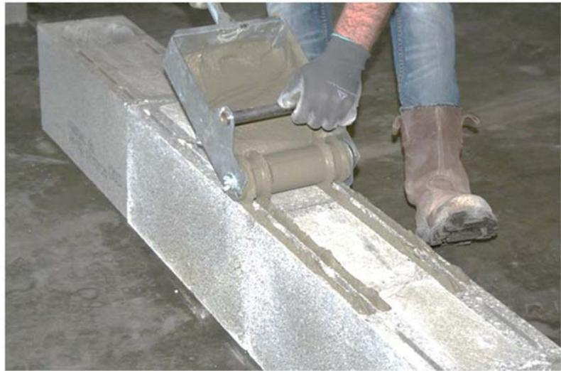
Figure 5 - Rouleau pour FABTHERM AIR 1.8
