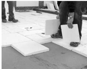
Mise en place des dallages (ici des dalles Castellane en opus multifformat) sur lit de sable parfaitement de niveau.
