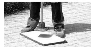
Compacter en utilisant une plaque vibrante protégée par un feutre.
