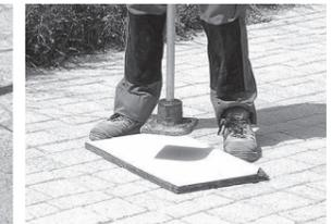
Compacter en utilisant une plaque protégée par un feutre.
