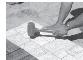
Ajuster la position des pavés à l'aide d'un maillet en caoutchouc.
