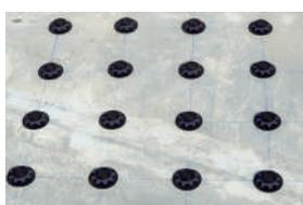
Tracez le calepinage au sol et positionnez les plots aux intersections.
