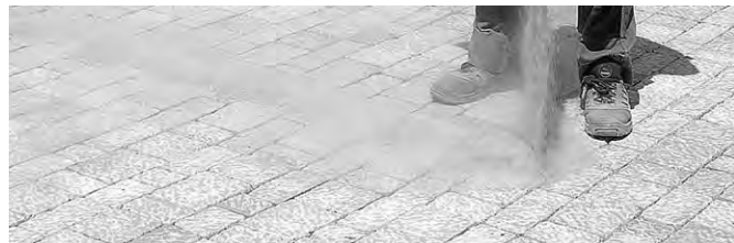
Utiliser un sable fin versé directement sur la surface pavée.
