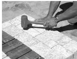
Ajuster la position des pavés à l'aide d'un maillet en caoutchouc.
