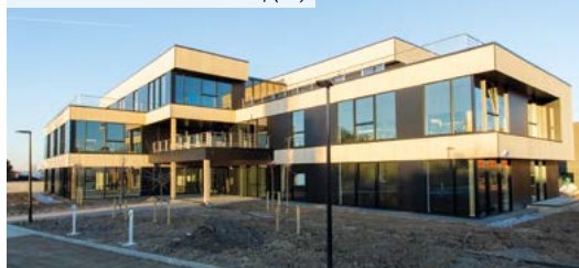
La Pilaterie – Villeneuve-d'Ascq (59)
