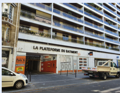
Plateforme du bâtiment - Rue Gros - Paris (16 ème )
