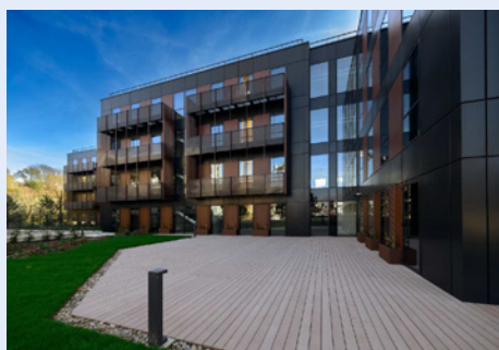
Siège de l'Andra - Chemin de la Croix Blanche - Châtenay Malabry (92)
