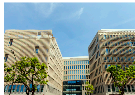
Immeuble Lebon Lamartine 126/138 avenue de Stalingrad - Villejuif (94)
