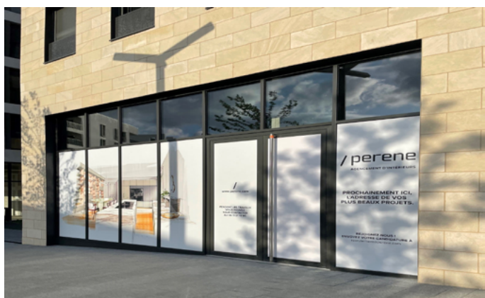
Travaux en cours pour l'ouverture prochaine du cuisiniste «Perene»
