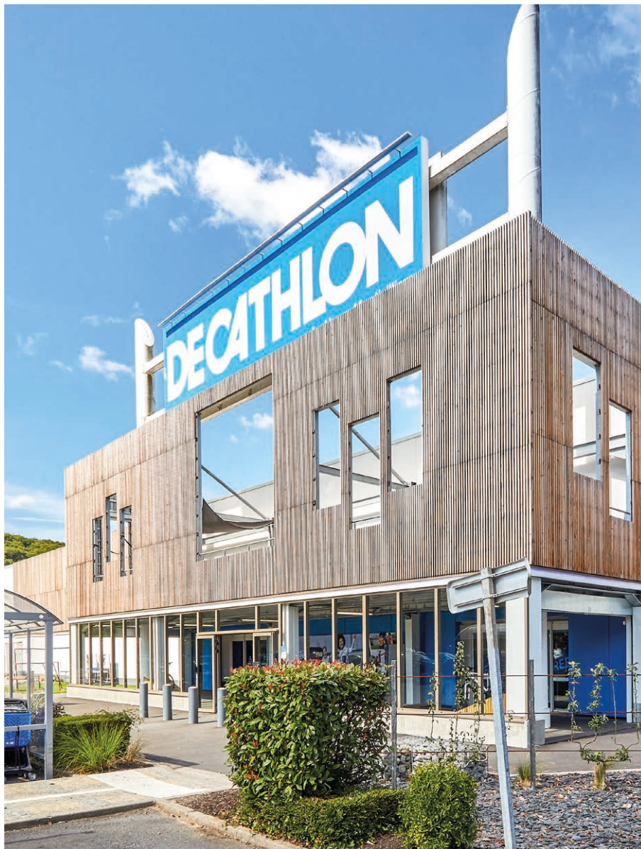
Centre commercial La Lézarde - Montivilliers (Le Havre)
