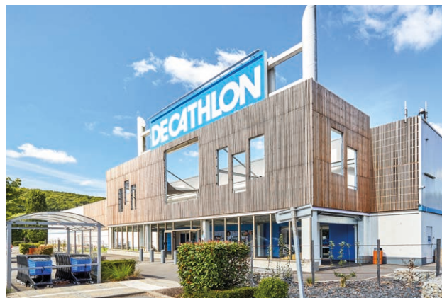
Centre commercial La Lézarde - Montivilliers (Le Havre)
